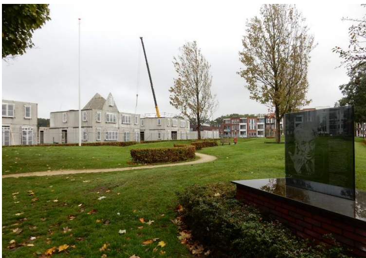
Foto: Riet Mensink-Lelifeld Laares in aanbouw!
